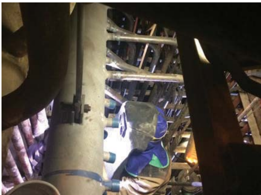
Přivařování trubkovnic přehříváku na komoru přehříváku
