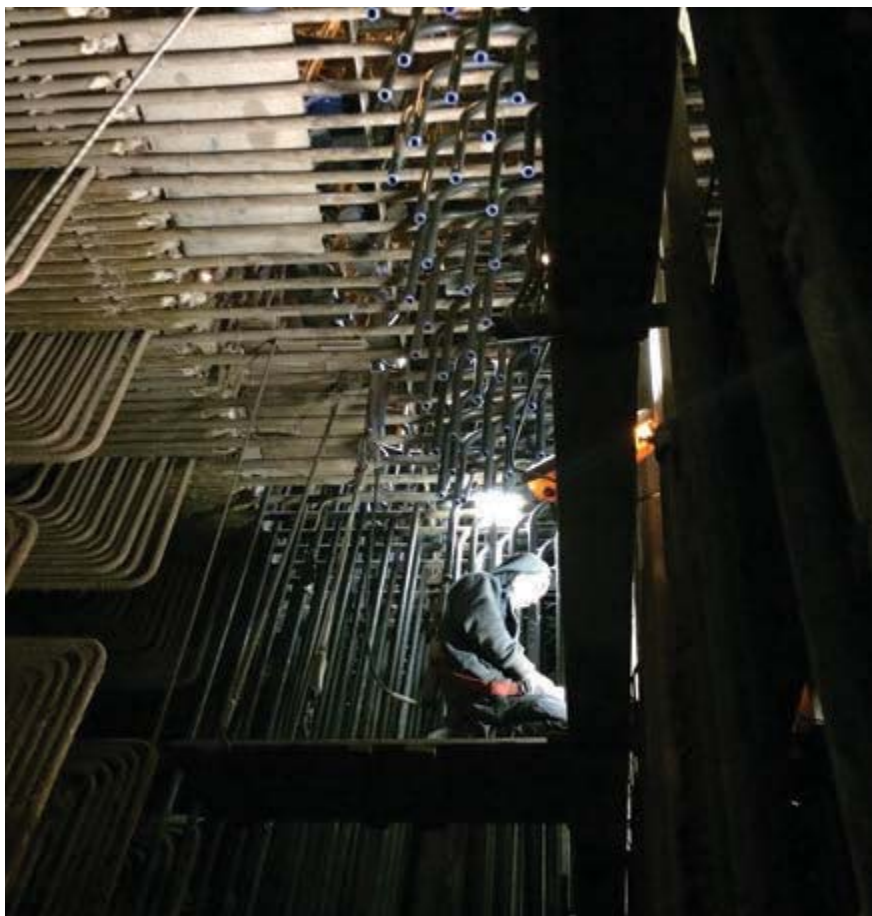
Přehřívák – napojování horní části na středovou
