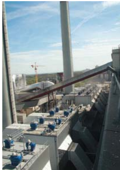
Pohled na objekty nových tkaninových filtrů
