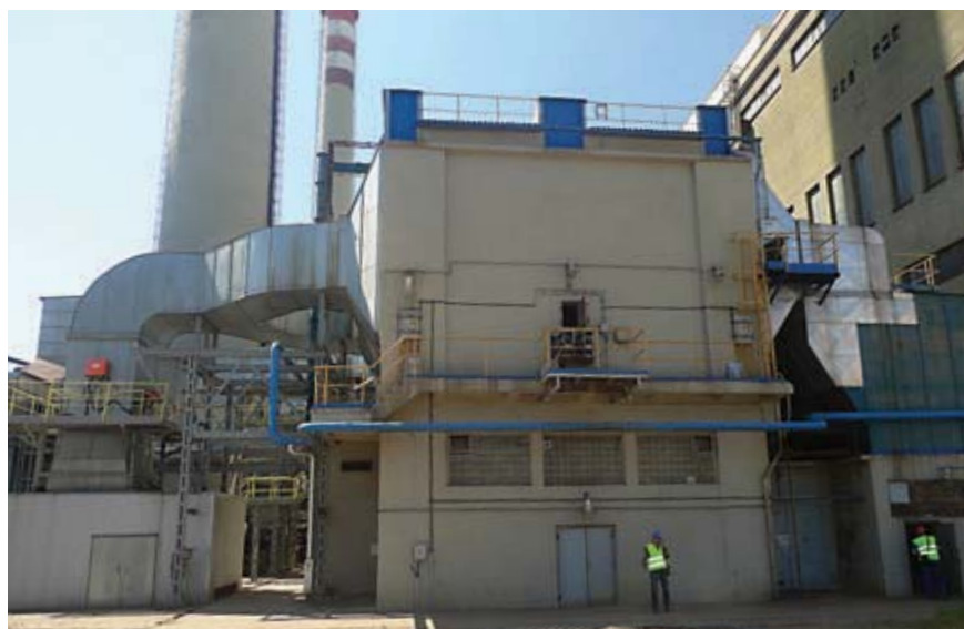
Stávající elektrostatický odlučovač
