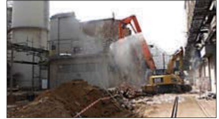
Demolice stávajících odlučovačů
